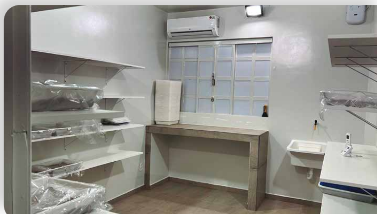
Imagens de sala interna do LAS Ponta Grossa após realização de obras
